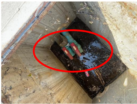
รูปที่ 5 ระบบท่อและวาล์วประตุน้ำ
