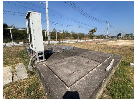
รูปที่ 2 ป่อ Inspection Manhole
